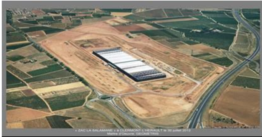
Figure 3 : Photo aérienne de l'emplacement de la centrale U de Clermont l'Hérault
