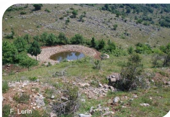
A Cahan, une lavogne a été récemment construite. Les éleveurs ne l'utilisent pas car elle a été mal conçue et mal réalisée (l'étanchéité plastique a été faite avec un matériel fragile et mal adapté qui s'est rapidement percé). Un éleveur raconte : « Ils ont fait un appel d'offre, mais nous n'avons pas été consultés... ils auraient mieux fait de nous donner l'argent, et nous, nous aurions fait quelque chose d'utile pour nos élevages ».
