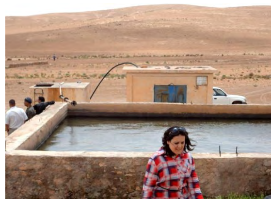
Photo 12 : Forage fonctionnel et bassin Berouth (Réalisation HCDS 2004)
