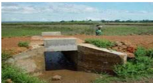
Figure 9. Ouvrage de franchissement (dalot) sur une piste dans la zone de Timbi Madina
