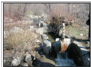
CANAL PLANDAIL Prise d'eau et vanne de réglage de débit
